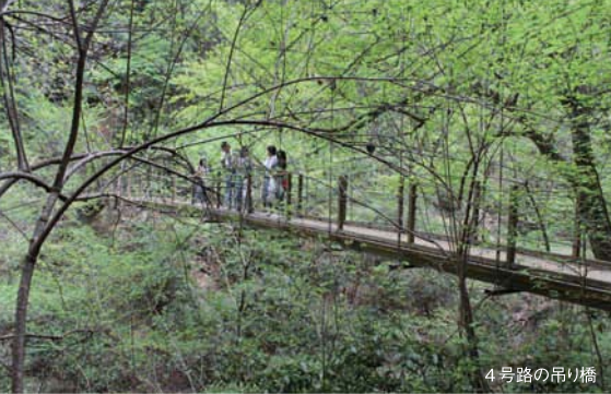
4号路の吊り橋
