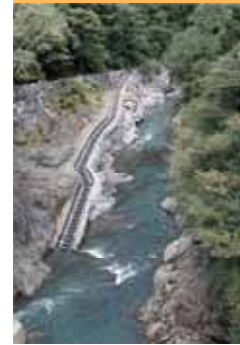
白丸ダム下流側の魚道。アユ、ヤマメ、サクラマスなどが上下流へ自由に行き来できる魚の通り道があります。
